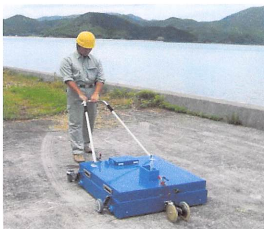
写真-2.2 アンテナ 200MHz 測定状況
