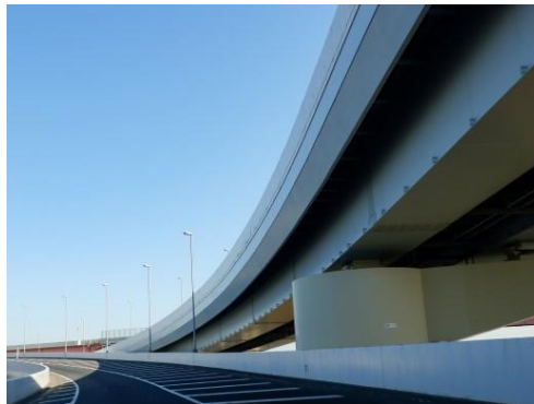
▶ 橋梁・高速道路の箱桁内部
