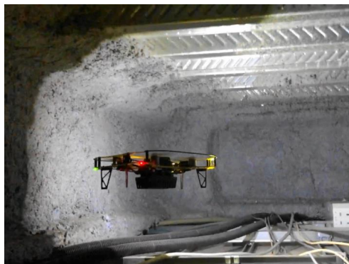
▶ 天井裏・地下ピット
